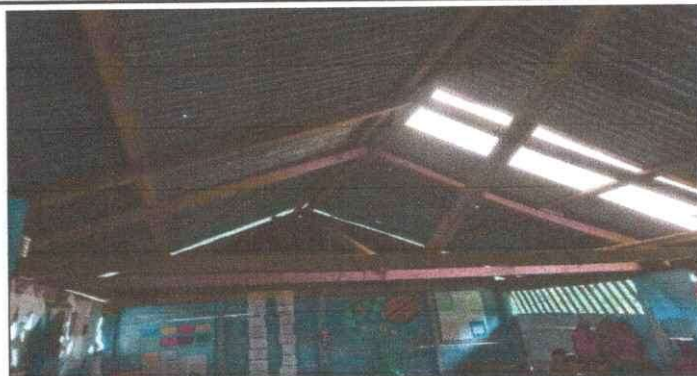
Foto 2: Cambio de estructura de techo y cubierta de lamina
