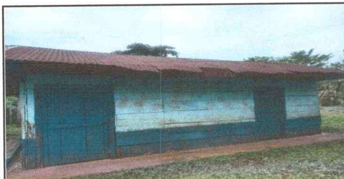
Foto 5: Levantado de block y cambio de piso de esta aula
