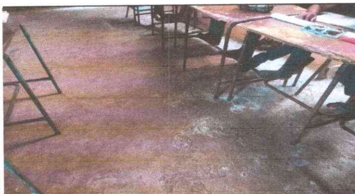
Foto 3: cambio de piso
